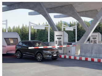
Barrières de péage
